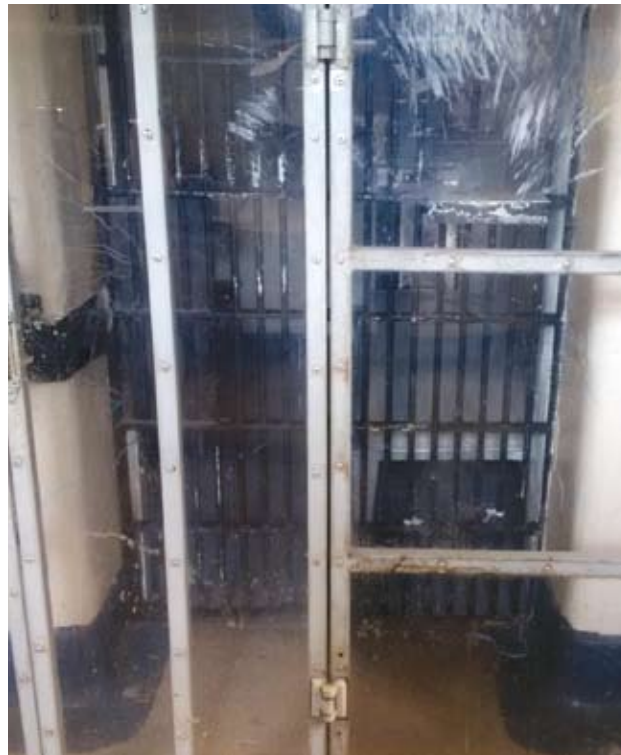
Porte de la cellule d'isolement couverte de plexiglas de sécurité.
