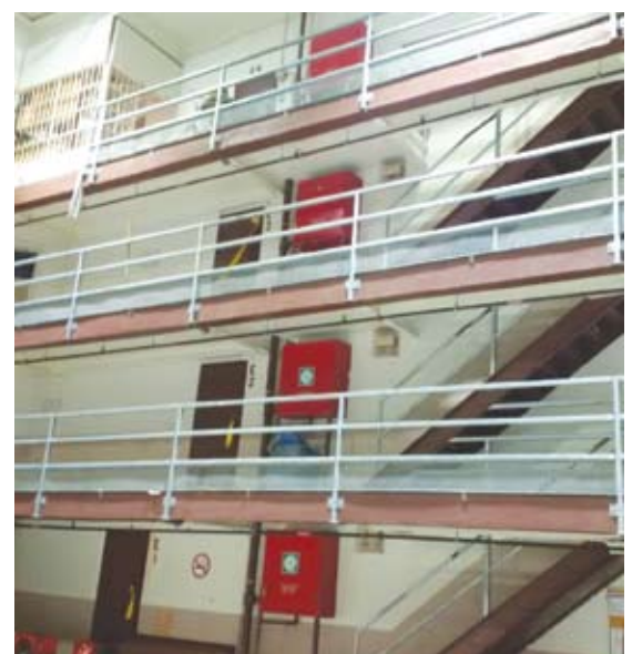
Entrée des unités E1/2 et E3/4
