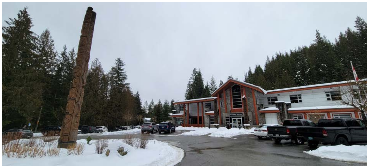
Bâtiment principal du Village de guérison Kwikwëxwelhp (un pavillon de ressourcement administré par le SCC)
