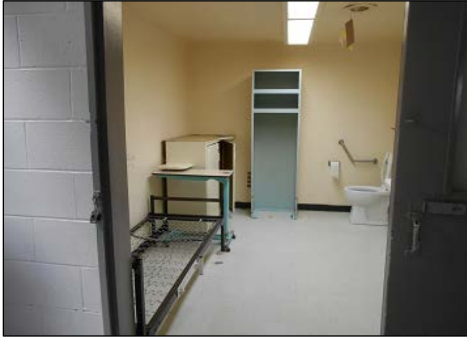
Centre fédéral de formation – Cellule accessible
